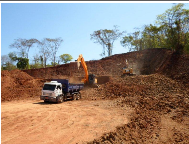
Figura 03: Abertura do terreno marcou início da Obra
