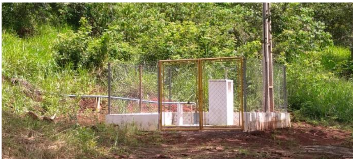
Figura 6 - Instalação do poço artesiano
