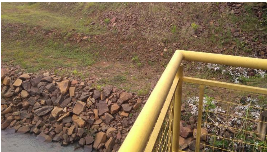
Figura 8 - Taludamento no canal de fuga
