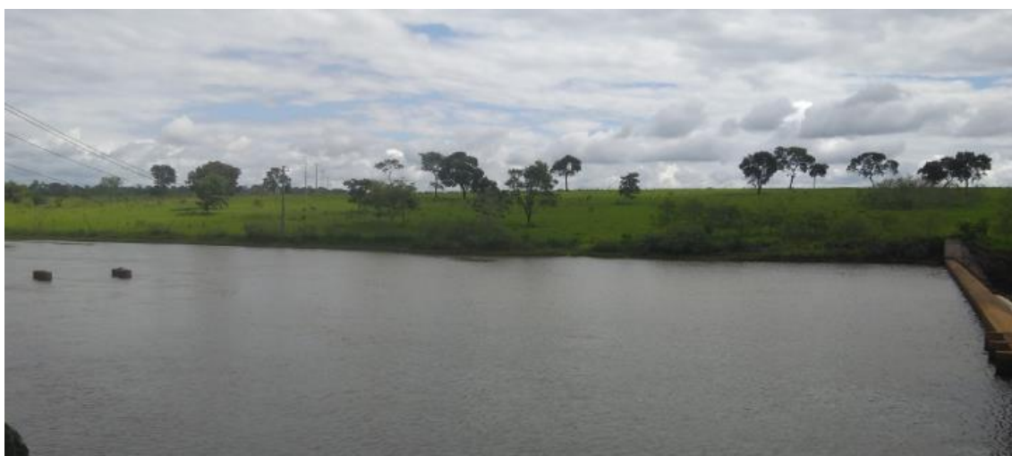
Figura 11 - Área do lago, margem esquerda
