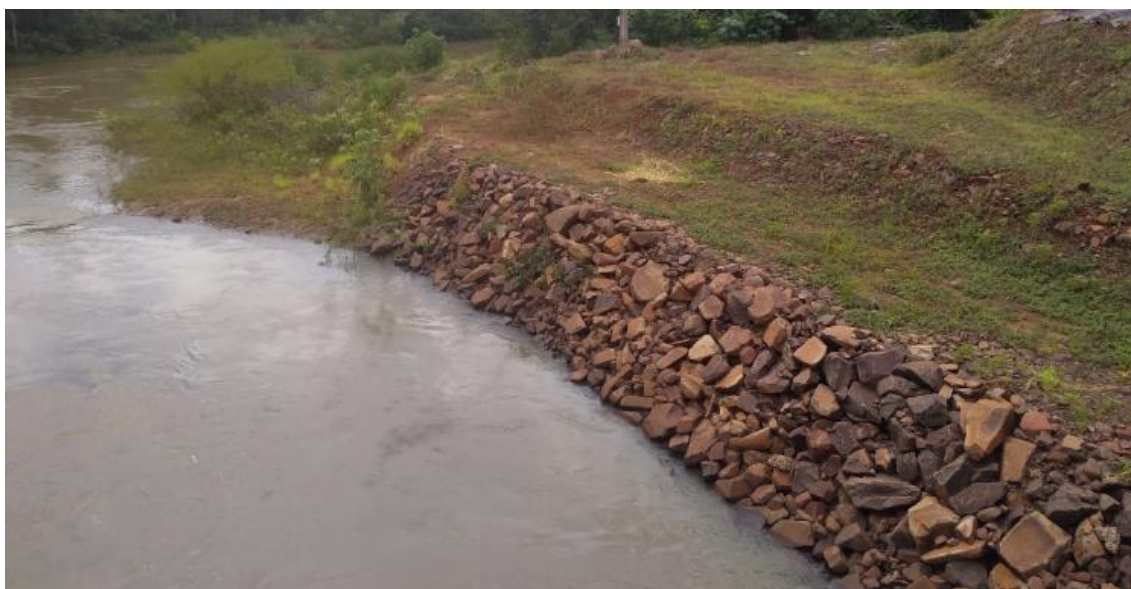
Figura 9 - Taludamento no canal de fuga
