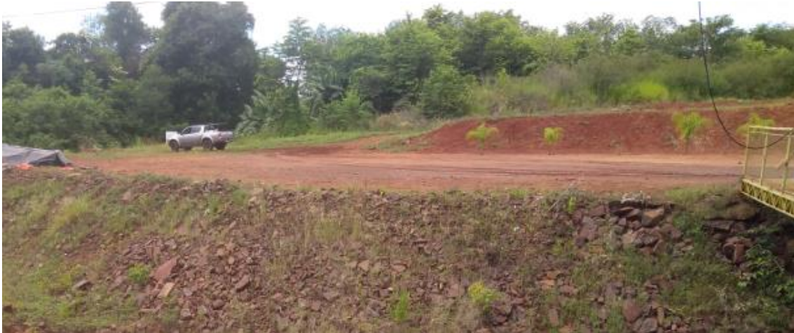
Figura 14 - Acesso à Casa de Força
