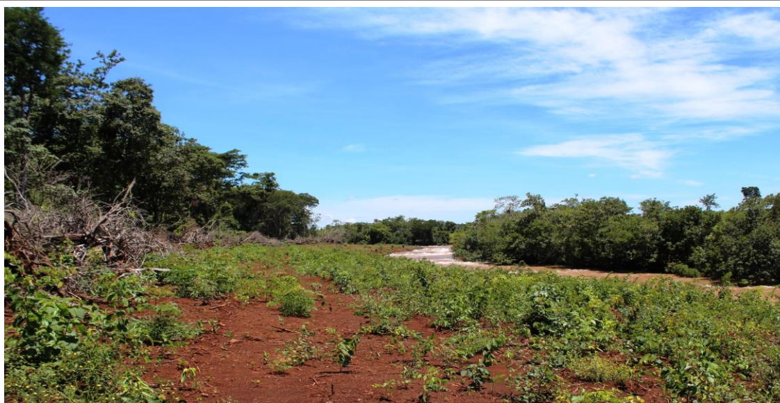
Figura 01: Preparação da área do futuro reservatório
