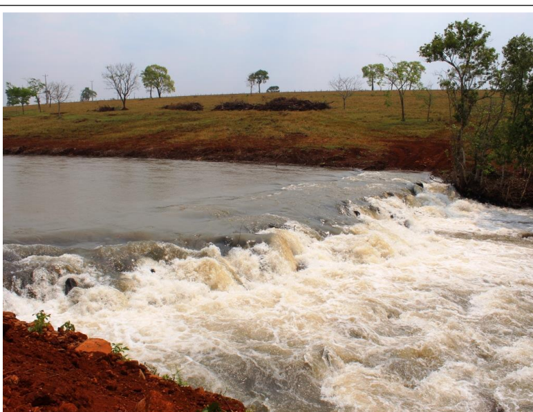
Figura 12: Ensecadeira parcial de rochas para a travessia do rio
