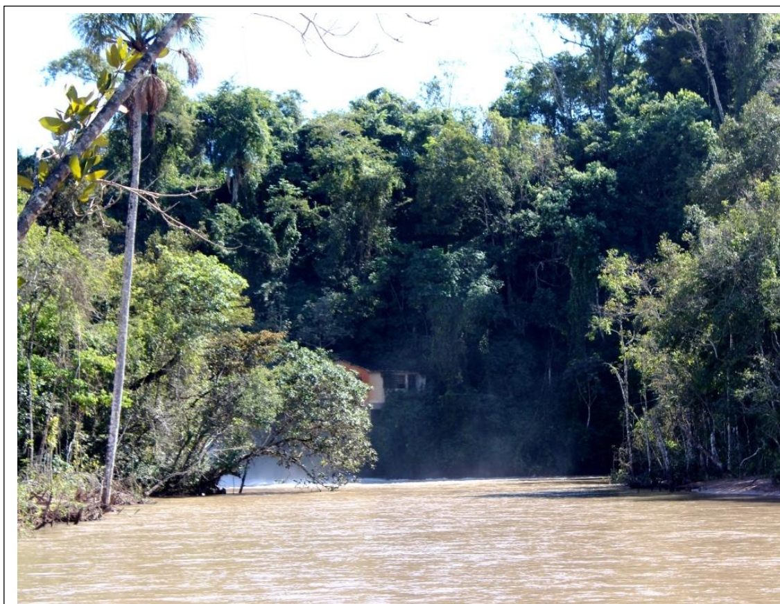
Figura 01: Matas protegidas no entorno da Obra. Ao fundo, estrutura de antiga CGH
